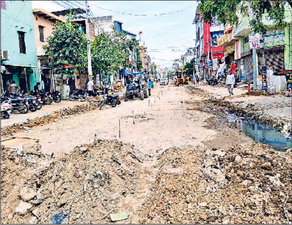
झज्जर। सड़क निर्माण के लिए हटाया गया मलबा और समतल की गई सड़क।
